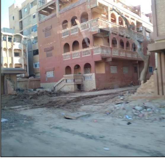
صورة (2) مبنى متعدد الطوابق متأثر بالكارثة الفيضانية
