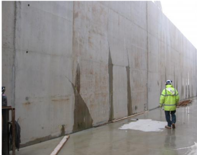
الشكل ( 7.15 ) تشققات الانكماش الحراري للخرسانة
