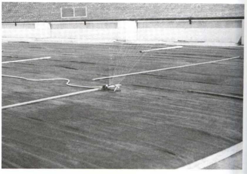
الشكل (3.8) طريقة نثر المياه 12.1
