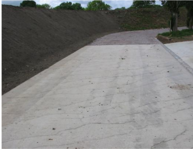
الشكل ( 5.15 ) تشققات الانكماش اللدن للخرسانة
