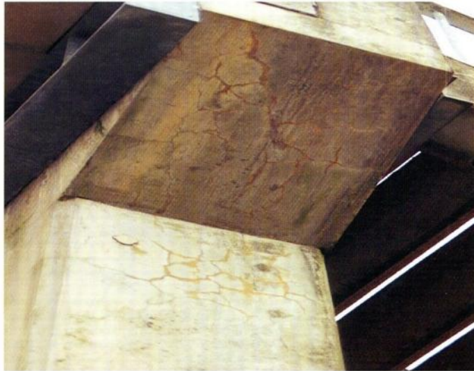
الشكل ( 15.15 ) تشققات تفاعل القلويات مع السيليكا في الخرسانة
