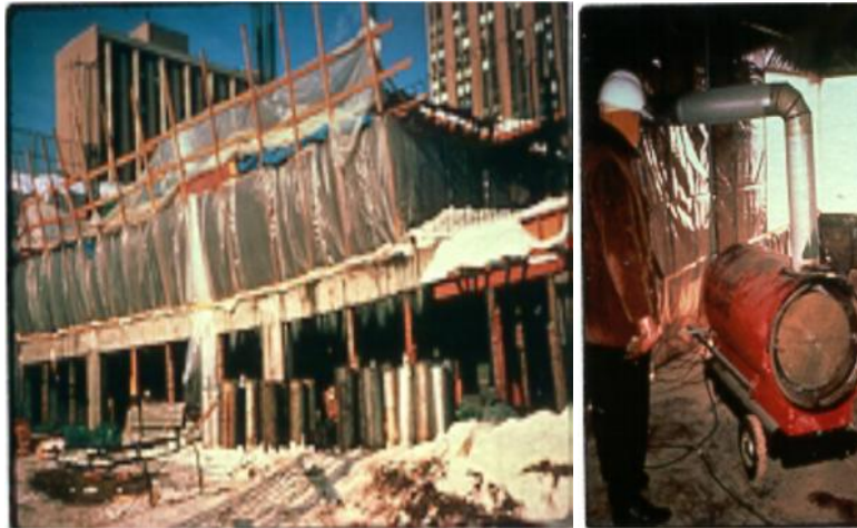
الشكل ( 3.16 ) استعمال الألواح البلاستيكية لمعالجة الخرسانة والتزويد بالحرارة 12.1
