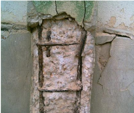
الشكل (6.12) صدأ حديد التسليح نتيجة وجود كلوريدات داخل الخرسانة
