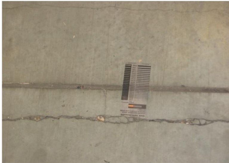
الشكل ( 9.15 ) تشققات الانكماش الجاف للخرسانة
