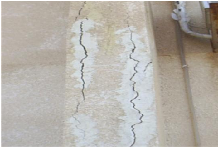
الشكل ( 13.15 ) تشققات تآكل حديد التسليح في الخرسانة
