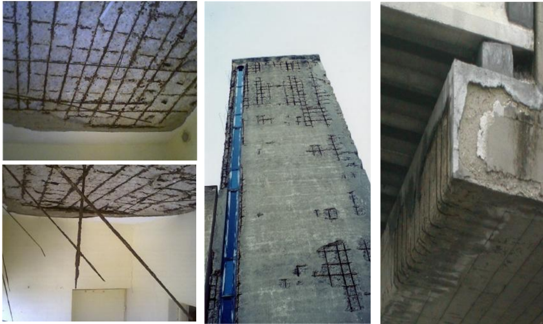
الشكل (2.12) تآكل حديد التسليح بالخرسانة
