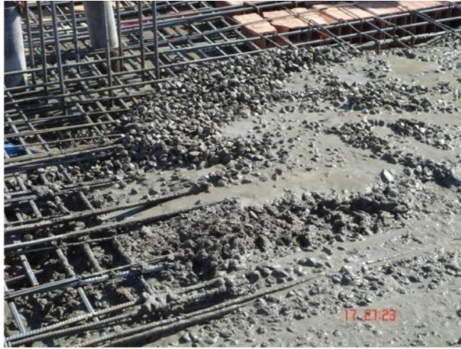
الشكل (6.10) انفصال مكونات الخرسانة
