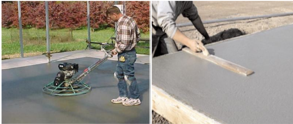
الشكل (12.7) الطريقة اليدوية والميكانيكية لتسوية سطح الخرسانة 2.6
