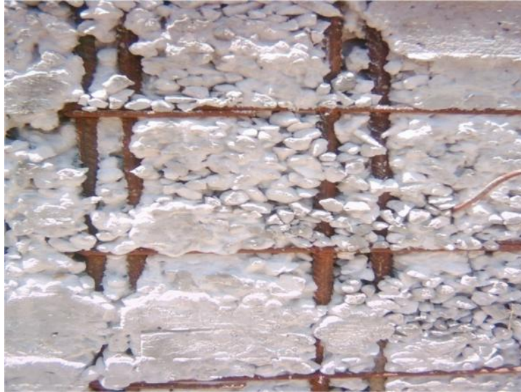
الشكل ( 11.15 ) تشققات التعشيش في الخرسانة
