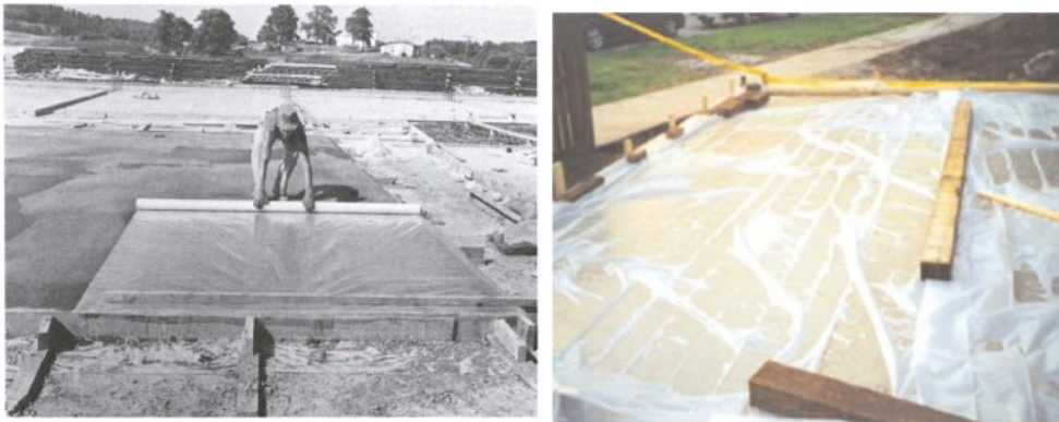
الشكل (5.8) طريقة الألواح البلاستيكية 12.1
