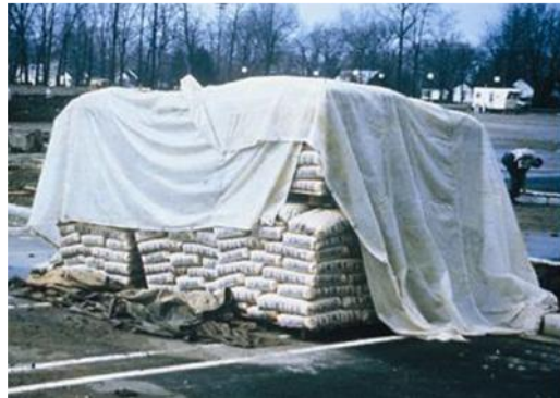
الشكل (1.7) طريقة تخزين الإسمنت
