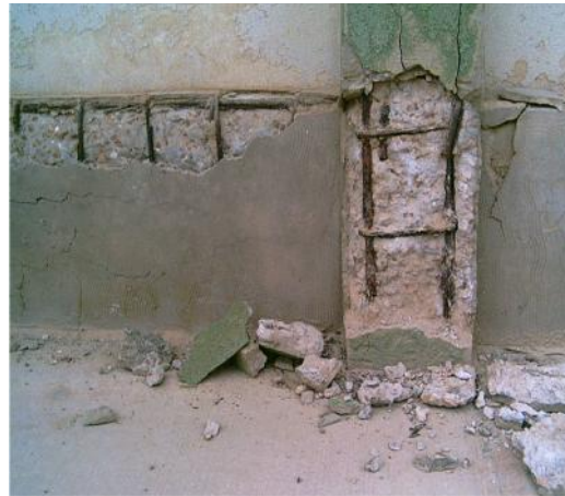
الشكل (6.12) صدأ حديد التسليح نتيجة وجود كلوريدات داخل الخرسانة
