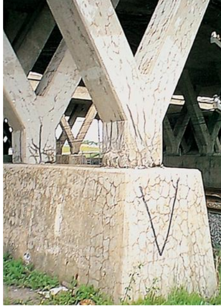
الشكل (9.12) تشققات نتيجة تفاعل القلويات مع السيليكاً
