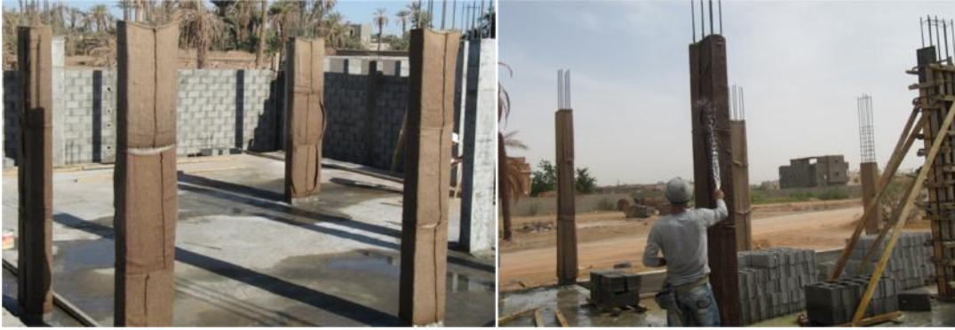
الشكل (4.8) طريقة الأغشية المبللة
