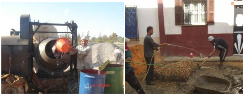
الشكل (3.7) طريقة خاطئة لإضافة الماء
