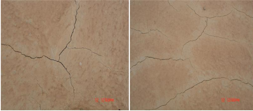
الشكل (8.9) التشققات المرنة في الخرسانة
