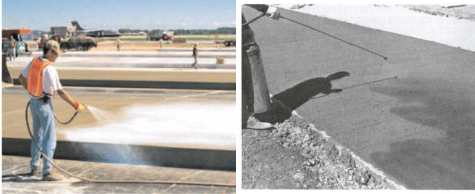
الشكل (7.8) طريقة الأغشية الكيميائية
