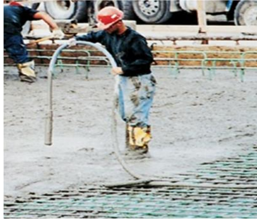
الشكل (10.7) دمك الخرسانة ميكانيكياً 2.6
